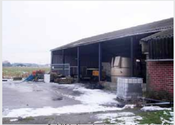
Bedrijfsbebouwing Laarstraat 9, achterzijde
